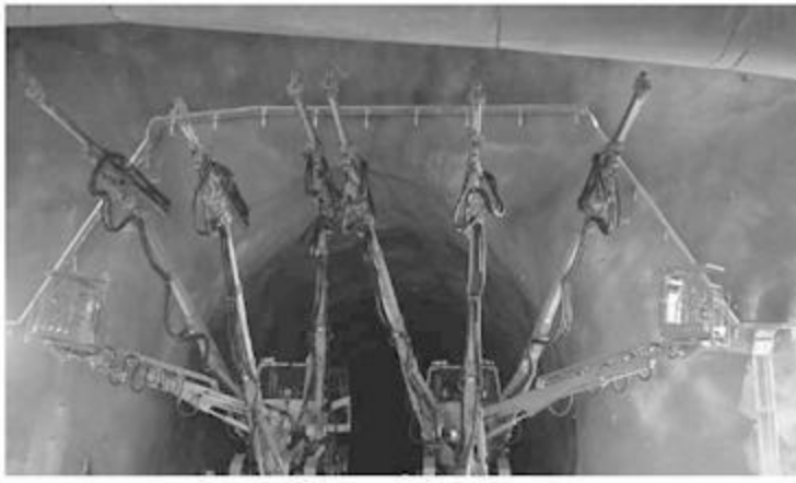
Các kết cấu hỗ trợ được chuẩn bị trước nhằm kích hoạt các khối chất nổ dọc tuyến đường sắt NEAT (Tuyến đường sắt bắc ngang An-pơ mới), một đường hầm kéo dài 57km dưới chân đèo Gotthard. Với chi phí ước tính 24 tỉ đô-la, đây là dự án xây dựng đắt đỏ nhất trong lịch sử Thụy Sĩ
