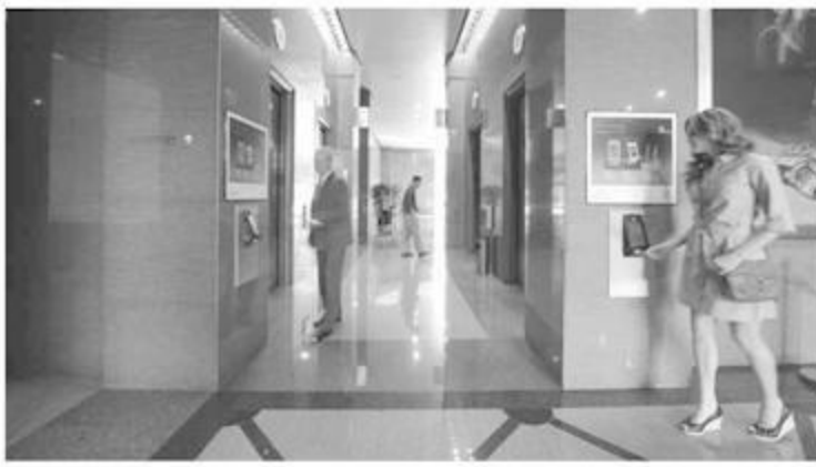
Schindler đã phát minh ra "hệ thống hiệu triệu đích đến" cho phép hành khách xuất hiện tại điểm đến được chọn dễ dàng thông qua một lộ trình tối ưu
