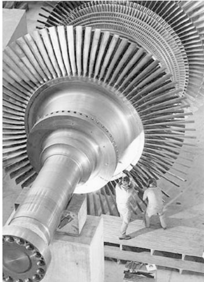
Tua-bin hơi nước của Brown Boveri (năm 1977). Tua-bin này có đường kính 7m và là sản phẩm lớn nhất thế giới thời điểm đó
